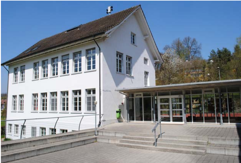
Die Räumlichkeiten befinden sich im Untergeschoss des Schulhauses
